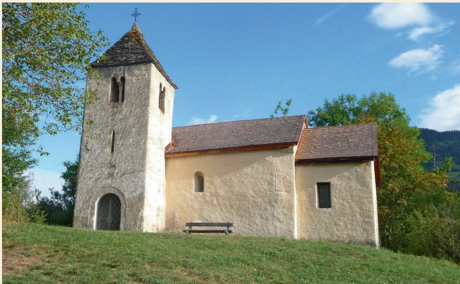
Die Kapelle St. Lorenz mit ihrem neuen Schindeldach.
