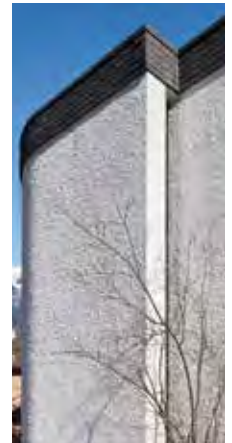
Ein schmales Fensterband grenzt in der ansonsten fensterlosen Westwand den Chor vom Schiff ab.
